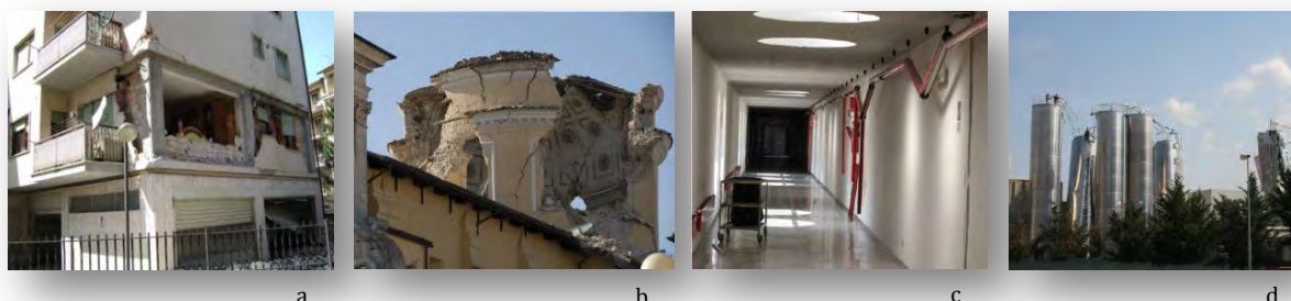
Slika 6.7.-1. – Primjeri oštećenja nakon potresa u Italiji (L'Aquila, 2009.) [9] (a. Stambena zgrada; b. Katedrala Duomo; c. Bolnica Saint Salvador; d. Industrijski spremnici)
